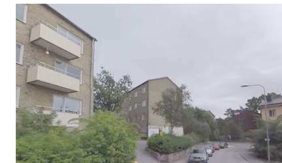
2. SYDVÄSTRA HUSGAVELN. VY FR HERTIGVÄGEN
