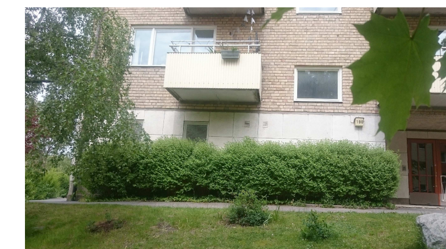
3. F D KONTORSLOKALEN. VY FR BLOMMENBERGSVÄGEN
